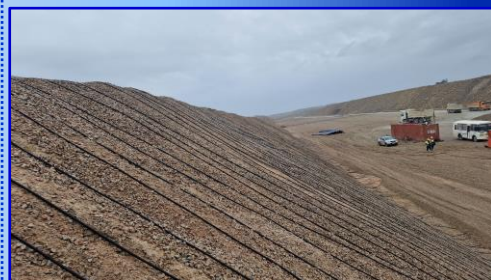
линии капельного орошения на склоне
