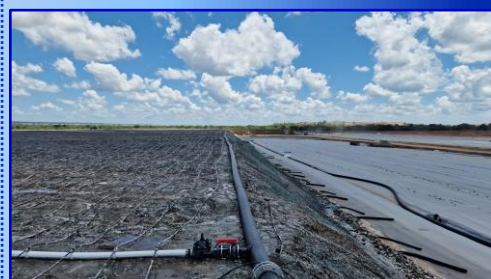
линии капельного орошения на склоне
